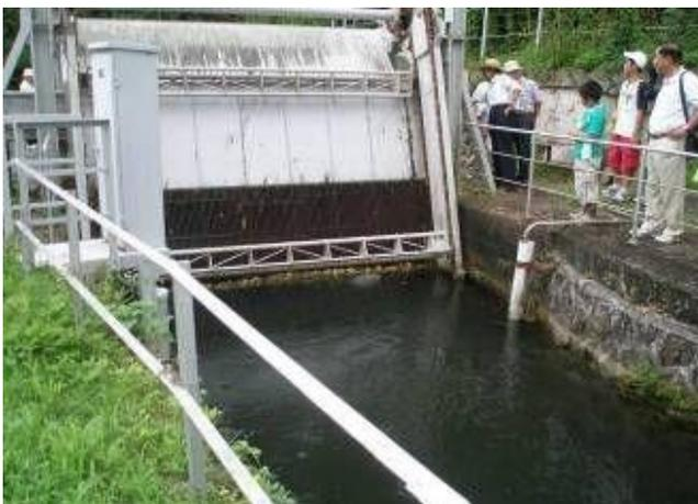
発電所の裏にある水の取り入れ口にあるゴミを取り除く装置です。ゴミがたまると掻き揚げられて、ベルトコンベアに乗せられ、ゴミ集積所に運ばれます。
