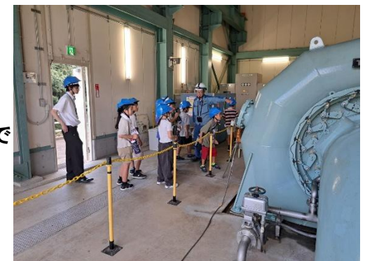
水力発電所の中、水車を見学
